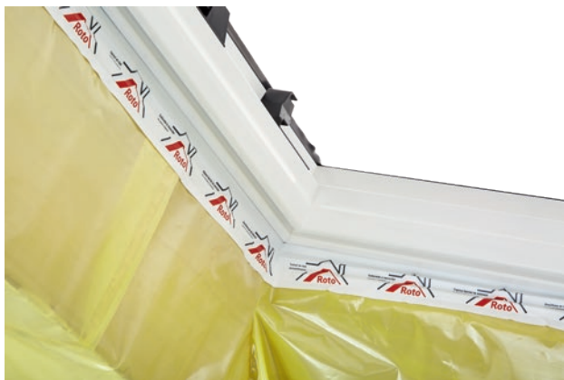
De aansluitmanchetten binnen gemonteerd
